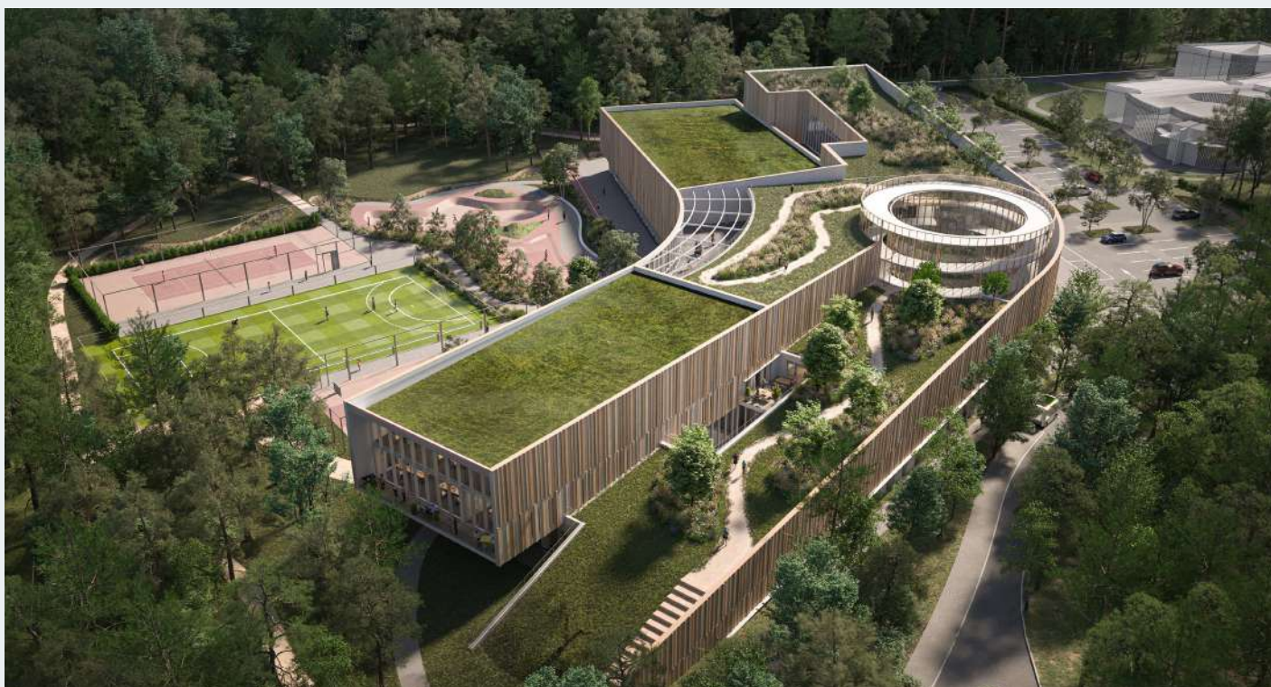
Vue aérienne du futur siège ISPC, conçue et réalisée par le cabinet d'architecture Moon Safari.
